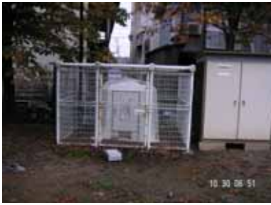
No.1 千手小学校（長岡市）
